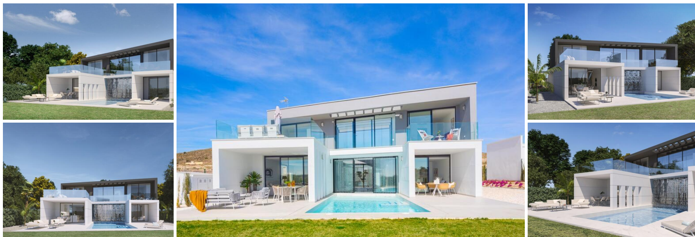
NYBYGGEDE VILLAER I ALTAONA GOLF RESORT, MURCIA
