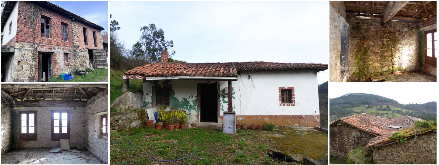
Stuehus med jord i Salas
