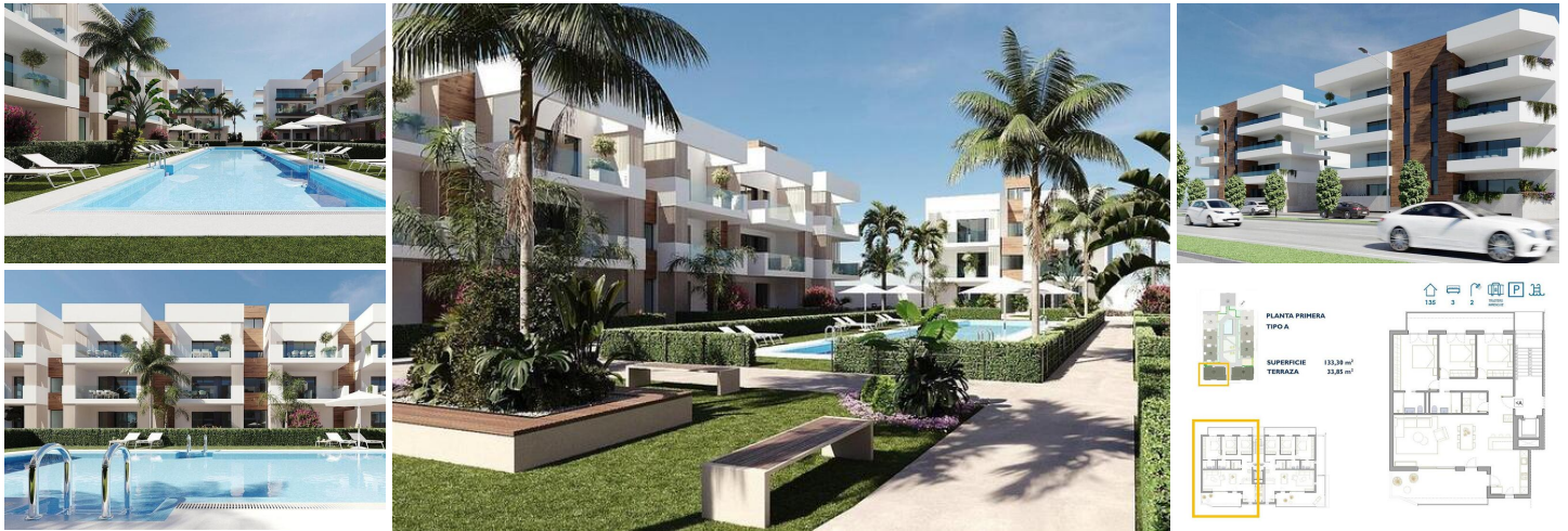
NYBYGGEDE BOLIGER I SAN PEDRO DEL PINATAR
